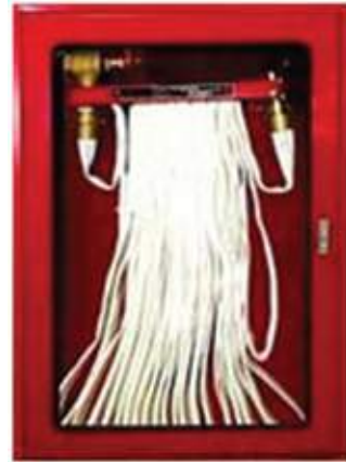
ชุดสายฉีดน้ำดับเพลิงแบบ Hose Rack ขนาด ๑ ๑ / ๒ นิ้ว
