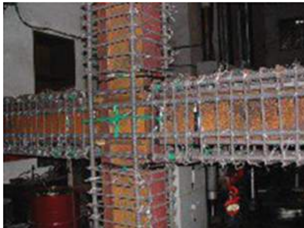
ข. ตัวอย่างงานก่อสร้างที่มีการหุ้มเสาและคานเหล็กด้วยคอนกรีต เพื่อป้องกันความร้อน
