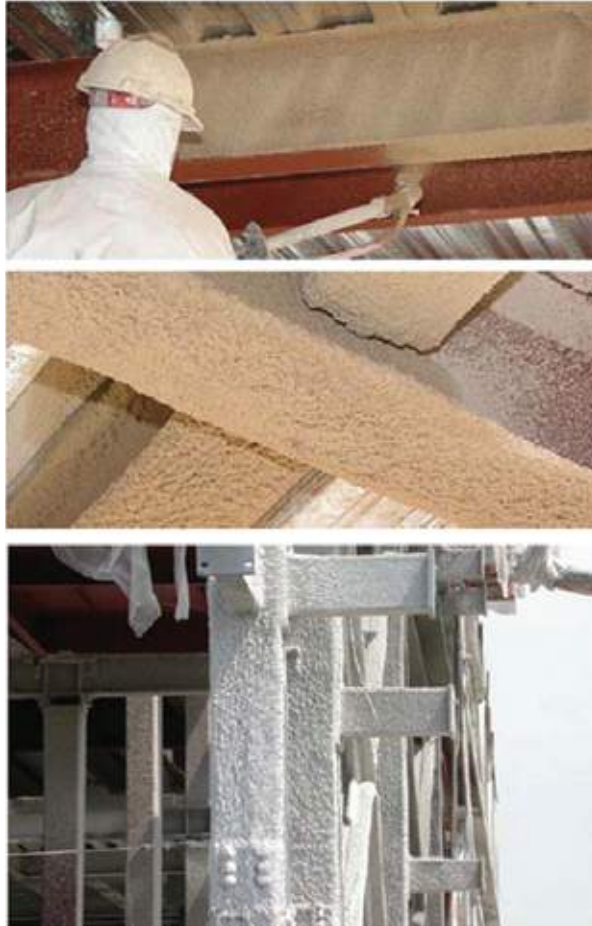
ภาพที่ ๔๕ การป้องกันโครงสร้างเหล็กโดยการพ่นด้วยวัสดุทนไฟ
